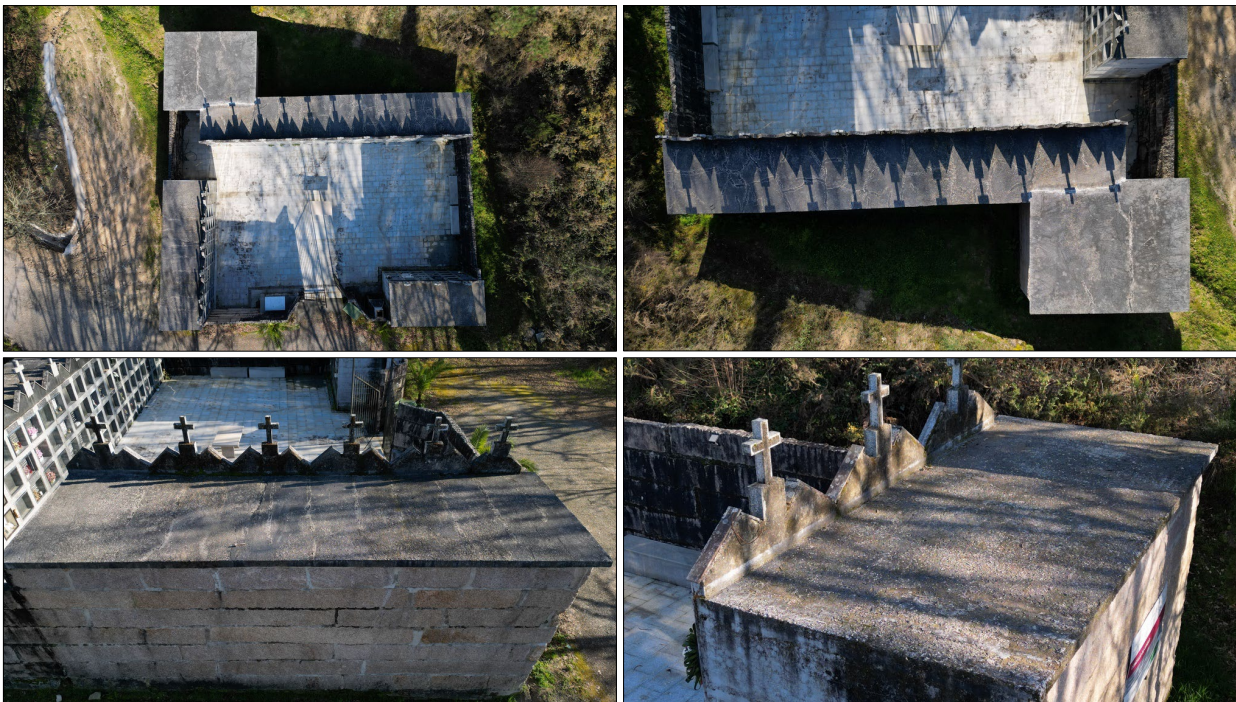
Estado de las cubiertas
